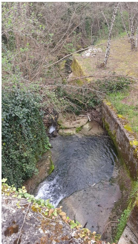
Comune di Capriglia Irpina (AV) Canale "Guarana"
