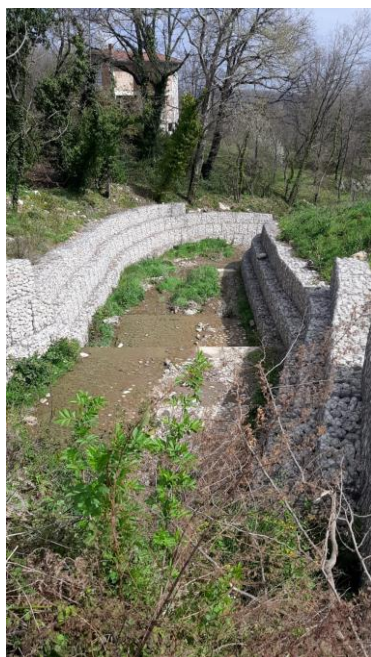
39.1 Summonte: Vallone 02, tratto con gabbioni
